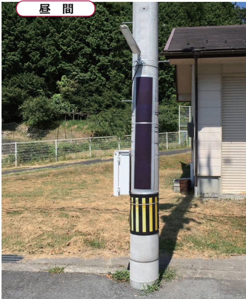
ストリートライトを電柱に巻いた例（兵庫県）※電柱使用には許可を得ています。
