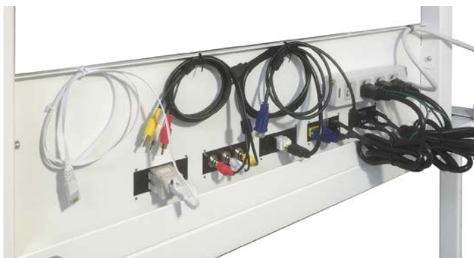
コネクターパネルと 4 口電源タップの使用例
