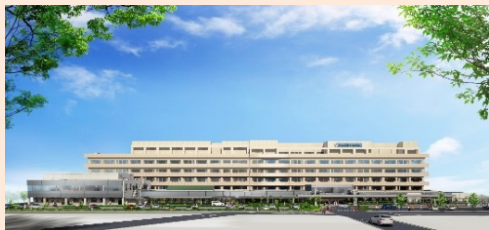
2019年竣工予定の聖隷佐倉市民病院の 新病棟および手術棟。
