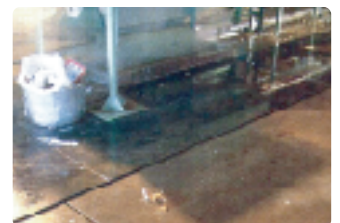
水作業の足場
