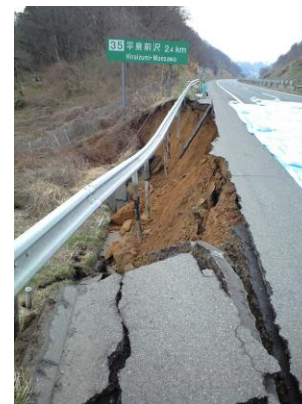
平泉前沢IC～水沢IC(上り線)の盛土変状
