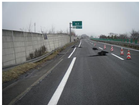
ひび割れが入った福島県の東北道国見IC付近
