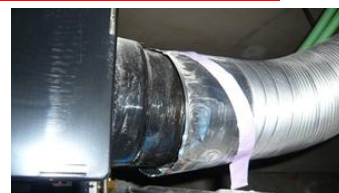
排気管（ダクト）接続不良
