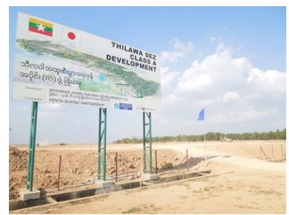
造成が進むティラワSEZ(2014年2月撮影)
