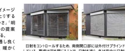
日射をコントロールするため、南側開口部には外付けブラインドを設置している。夏場は羽を閉じることで、日射を遮り、冬は室内に日射を取り入れる。微妙な角度の調整をしながら、通風も得ることができる。
