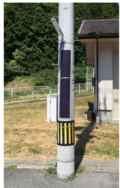
ストリートライトを電柱に巻いた例 （電柱使用には許可を得ています。）
