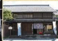
▲有力な商家であった「古山家」を 改修・復元した、ひし屋資料館
