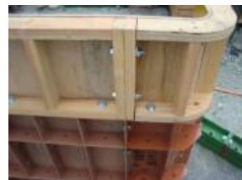
木製型枠との併用例
