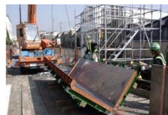
専用の冶具で吊上げも安全
