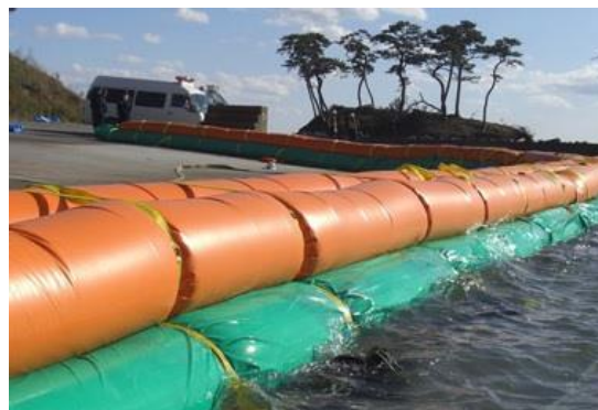
宮城県気仙沼市内漁港を守る『タイガーダム』
