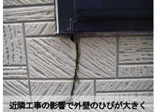
近隣工事の影響で外壁のひびが大きく
