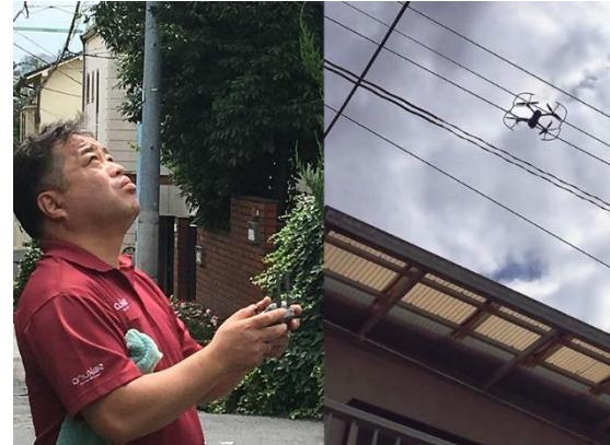
さくら事務所では建物を熟知した建築士のベテランインスペクターが自ら操縦するドローンで屋根の上空からの的確なポイントを空撮。映像から劣化の程度、不具合の有無を診断します。例えばドローン撮影の結果「屋根が錆びている、割れている」などの不具合が発見された場合、同じ箇所の屋根裏をインスペクターが調査して「シミ」などを確認できれば雨漏りの可能性が強くなります。インスペクター自身が操作・調査を行うからこそ、その場で客観的な修繕アドバイスまで行えるのが特徴です。
