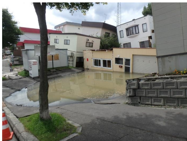
北海道胆振東部地震直後・液状化で流動化した被害箇所
