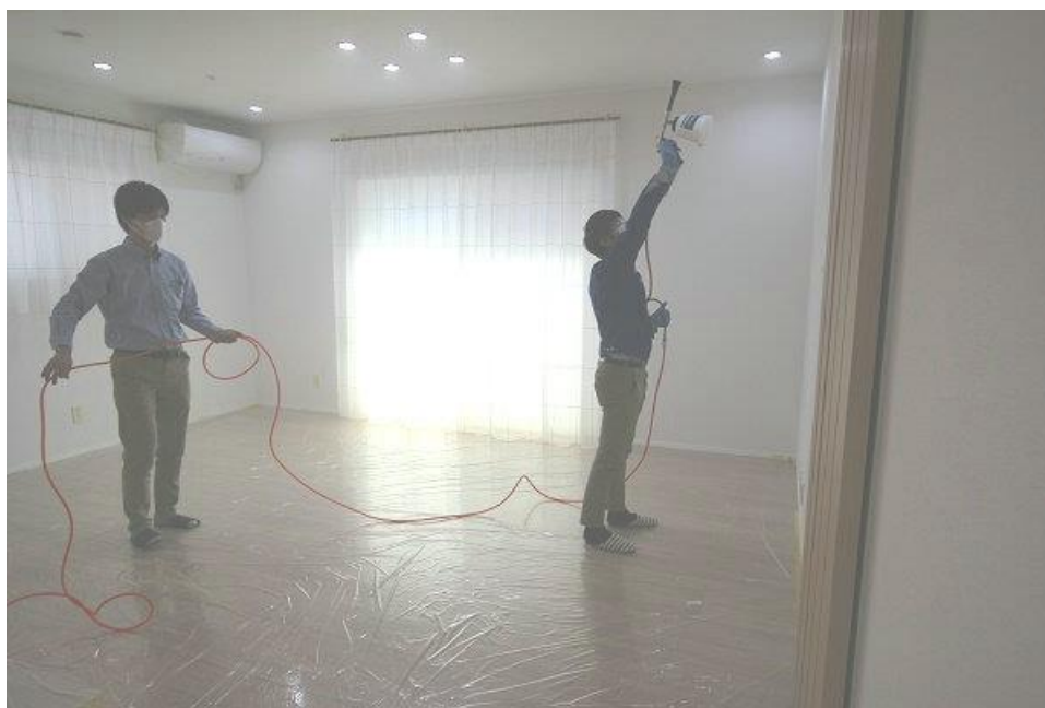
光触媒コーティング施工の様子
