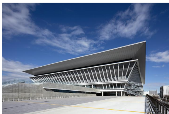
< 施工事例：「東京アクアティクスセンター」 >
