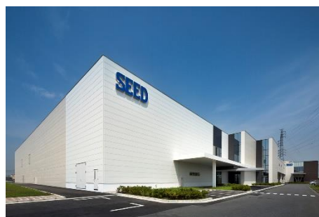
シード鴻巣研究所 2号棟外観
