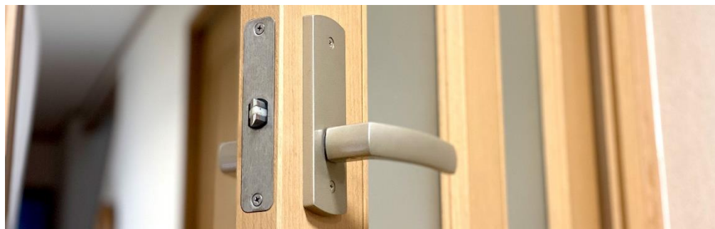
ドア金物(ハンドル類)は錠前装置が付随するため構造が複雑
