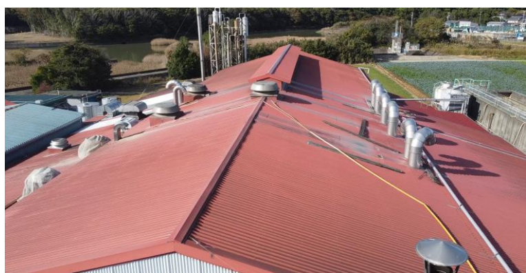
〈ドローン目線での工場の屋根〉
