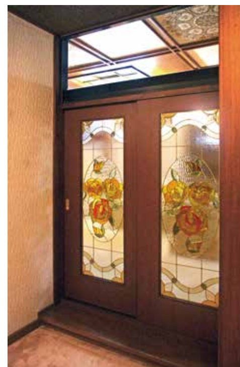
▲特注品(薔薇) 引違戸 元々ガラスの無いドアだったのを、ステンドグラスドアに交換しました。明るいリビングになったと非常に喜んでいただけました。
