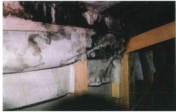
＜断熱材の施工不備を原因とする不具合事例＞
