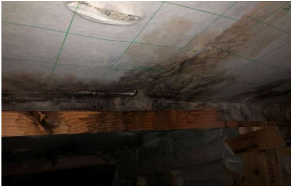
＜断熱材の施工不備を原因とする不具合事例＞
